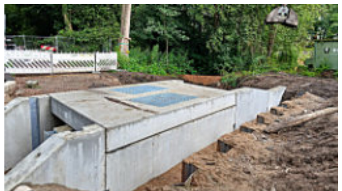
Das Durchlassbauwerk sorgt für den ungestörten Durchfluss der Wandse. Foto: Herr Kissel, Firma Weseloh
