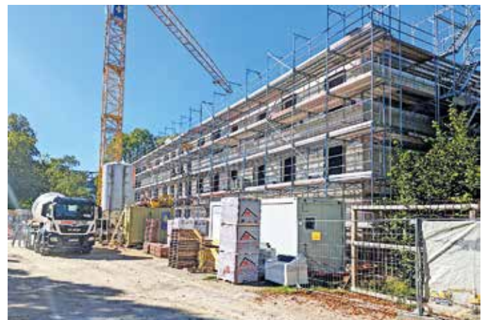
Trotz in Bau befindlicher Wohnungsprojekte wie hier in Tonndorf: Es fehlt an Wohnraum in Wandsbek.
