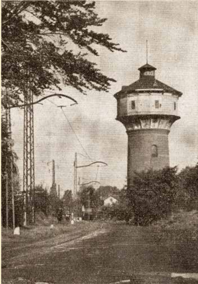
»Der Wandsbeker Wasserturm« Foto: Hans Chr. Heyer
