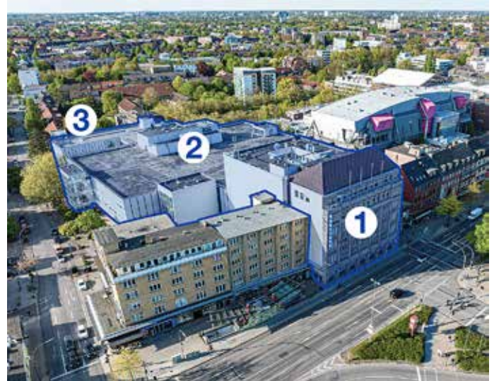
Der Altbau 1 mit seiner denkmalgeschützten Fassade bleibt erhalten. In den ehemaligen Karstadt Anbau 2 wird eine rechteckige Öffnung in das Dach geschnitten, um Licht für einen Innenhof zu erhalten.
