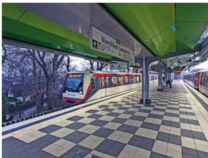
Der neu gestaltete U-Bahnhof Wandsbek-Gartenstadt nahm wieder den vollen Betrieb auf.
