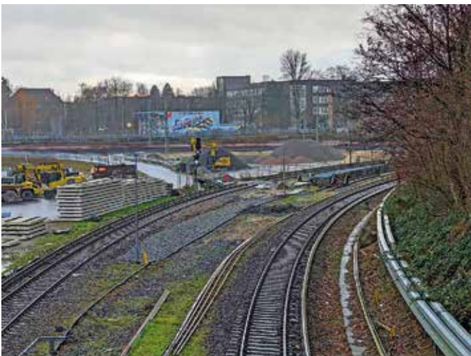
Ausbau der S4: Besonders in Kurvenbereichen entsteht viel Lärm – entsprechend wird in den Schallschutz investiert.
