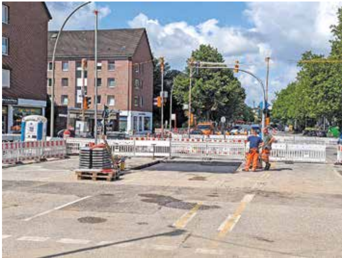
Die Baustelle auf der Wandsbeker Chaussee verursachte ein Verkehrschaos. Foto: Winfried Mangelsdorff
